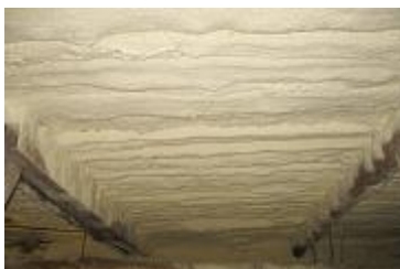
Структура шарів: 1) підлога, 2) поліуретан
